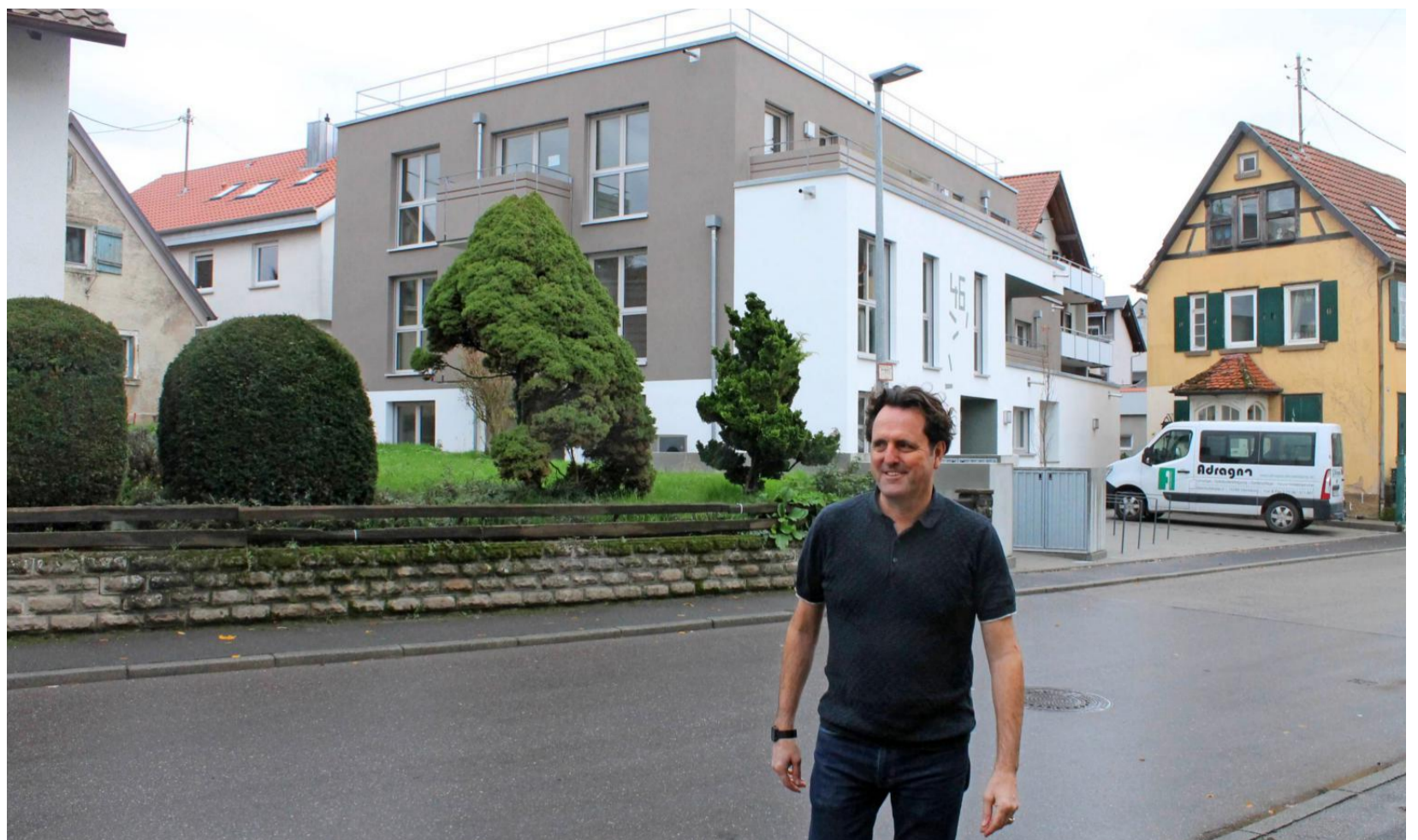
Klaus Fleisch setzt auf Nachverdichtung. Der Neubau (im Hintergrund) auf einem 508 Quadratmeter-Grundstück hat eine Wohnfläche von 390 Quadratmetern. Foto: Römer
